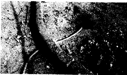
Foto 15 y 16: Tubería para Pozo puesta a tierra de 15<ohmios, se han hecho 4 pozos a tierra para esta descarga. POZO PUESTA A TIERRA
