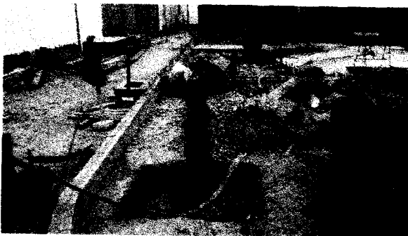
Foto 17 y 18: Pozo puesta a tierra de 15<ohmios, se han hecho 4 pozos a tierra para esta descarga. POZO PUESTA A TIERRA
